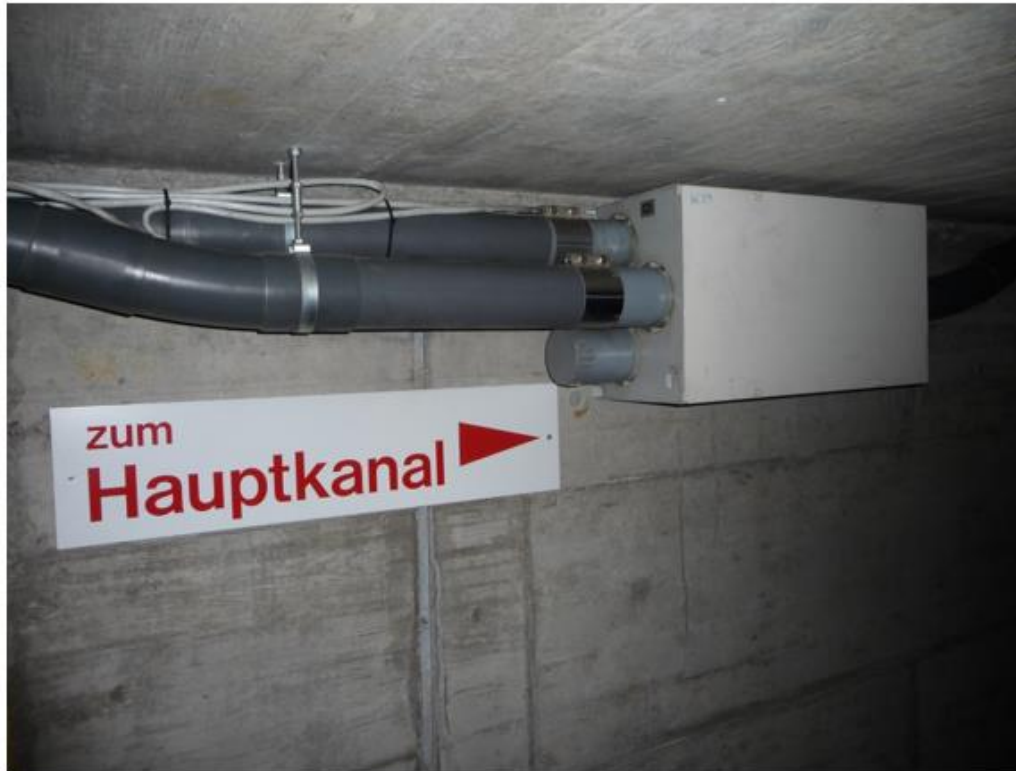
Abb. 64: Weiche Nr. 21 im Tunnelsystem
